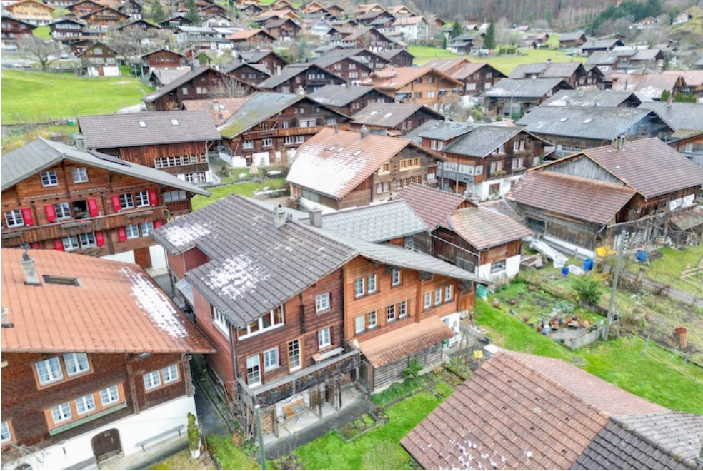
Auf dem Dach der Pilgerherberge Brienzwiler ist der Schnee schon fast wieder weg.
